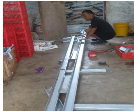
Gambar 1. Proses perakitan pembuatan rumah pengering
